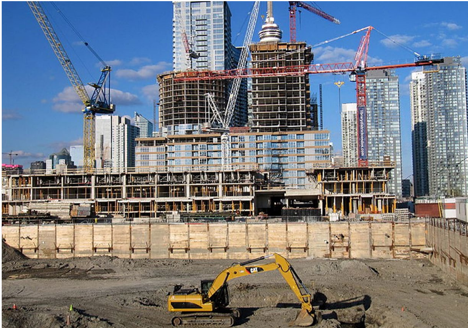
Baustelle in Toronto
